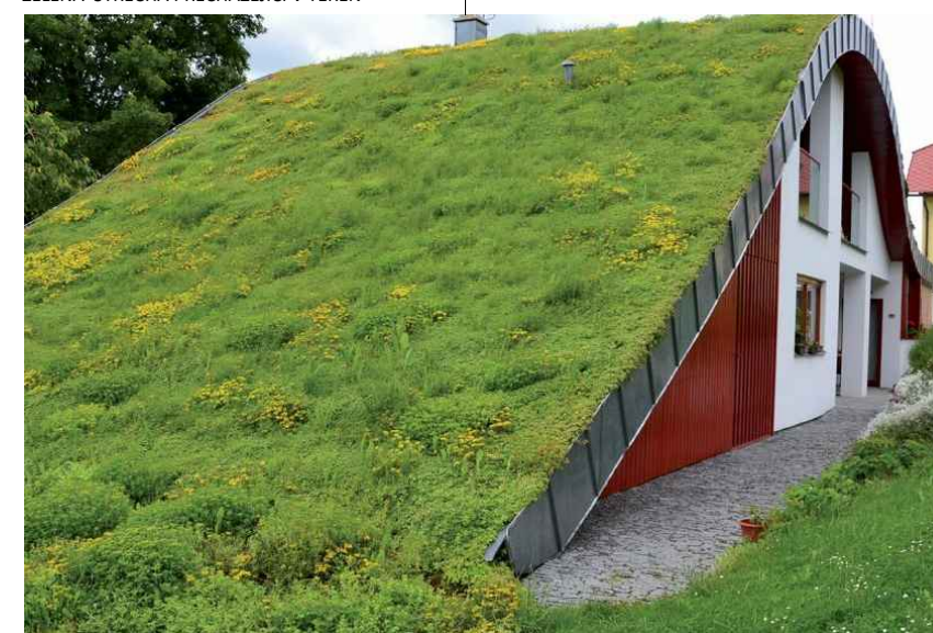
ZELENÁ STŘECHA PŘECHÁZEJÍCÍ V TERÉN
