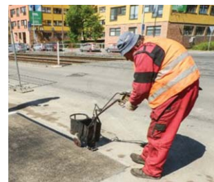
Zaasfaltování a provedení zálivky spáry
