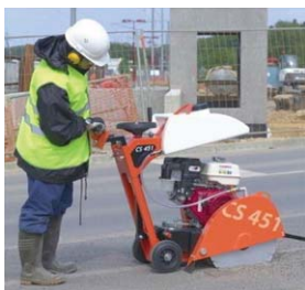
Řez asfaltového krytu
